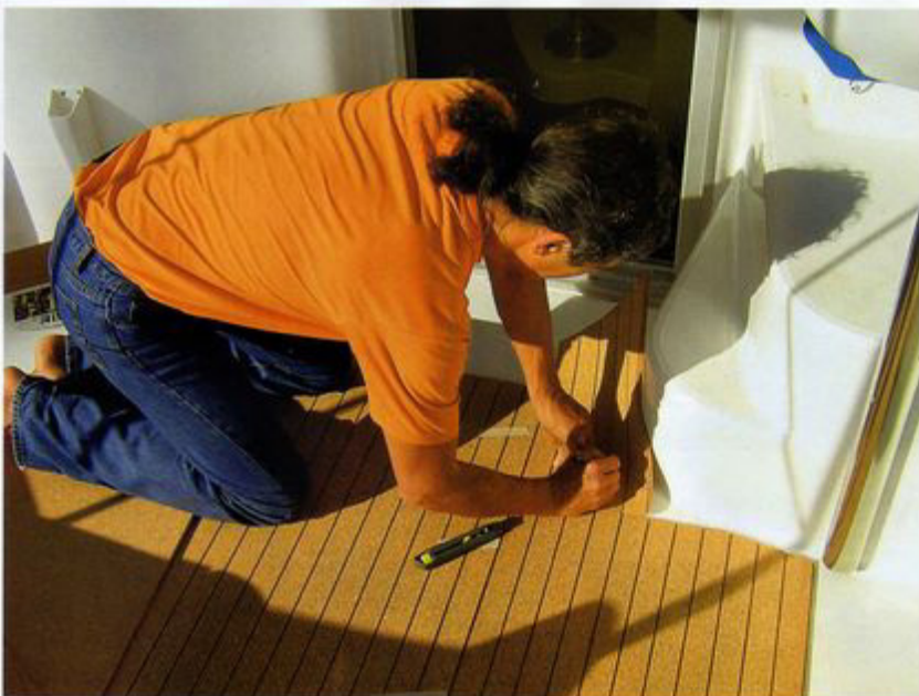
Die Platten von Seacork können einfach an Rundungen angeformt werden
