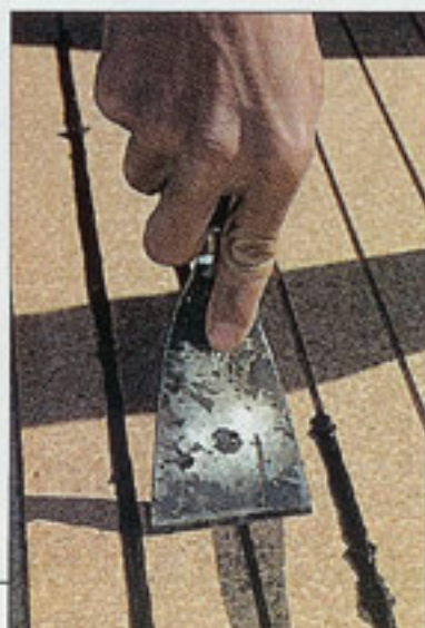
On utilise un mastic polyuréthane pour calfater les rainures.
