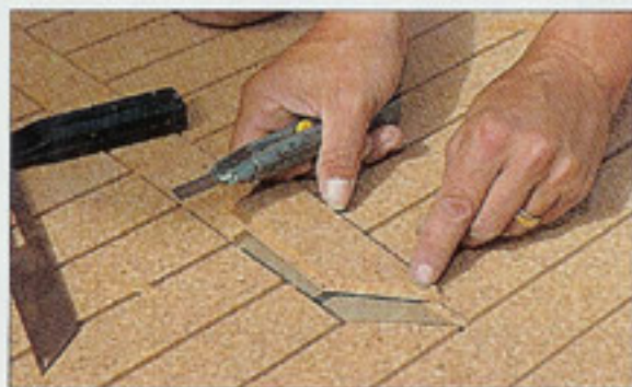
Facile à travailler, le liège se découpe au cutter.
